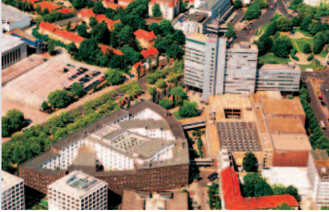
Der rbb in Berlin: Das Haus des Rundfunks, der Studiokomplex und das Fernsehsendezentrum
