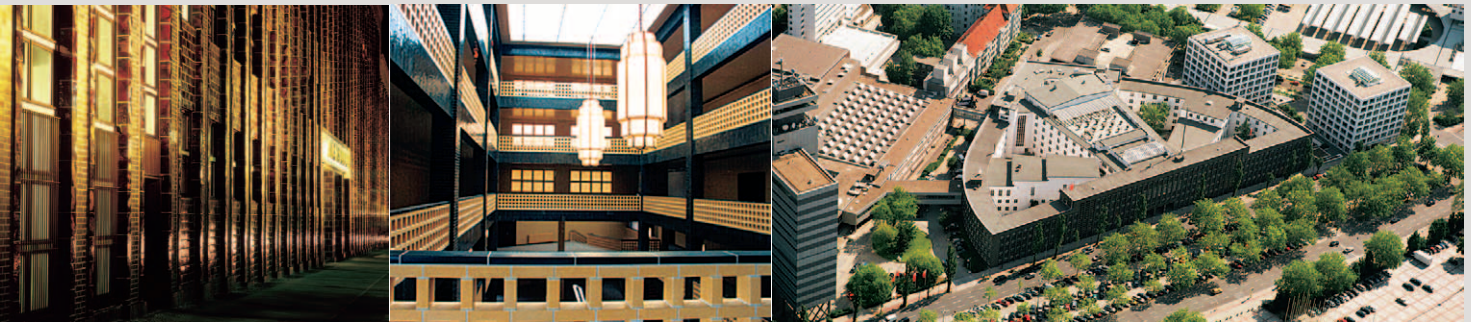
Haus des Rundfunks
